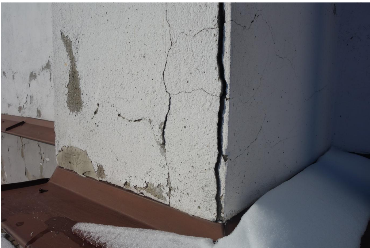
Fot.6 Widok na narożnik przypory od strony południowo-wschodniej.
