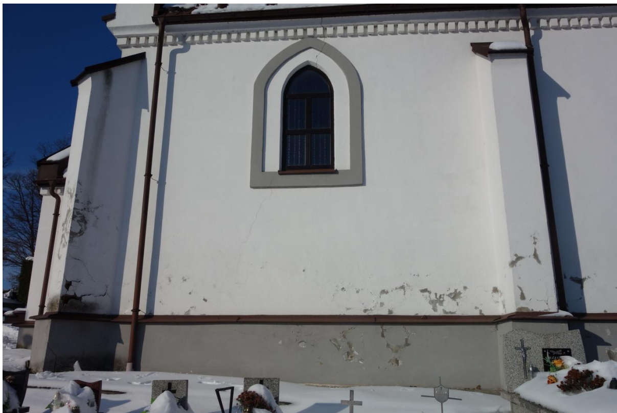
Fot.7 Widok na fragment elewacji od strony południowo-wschodniej.
