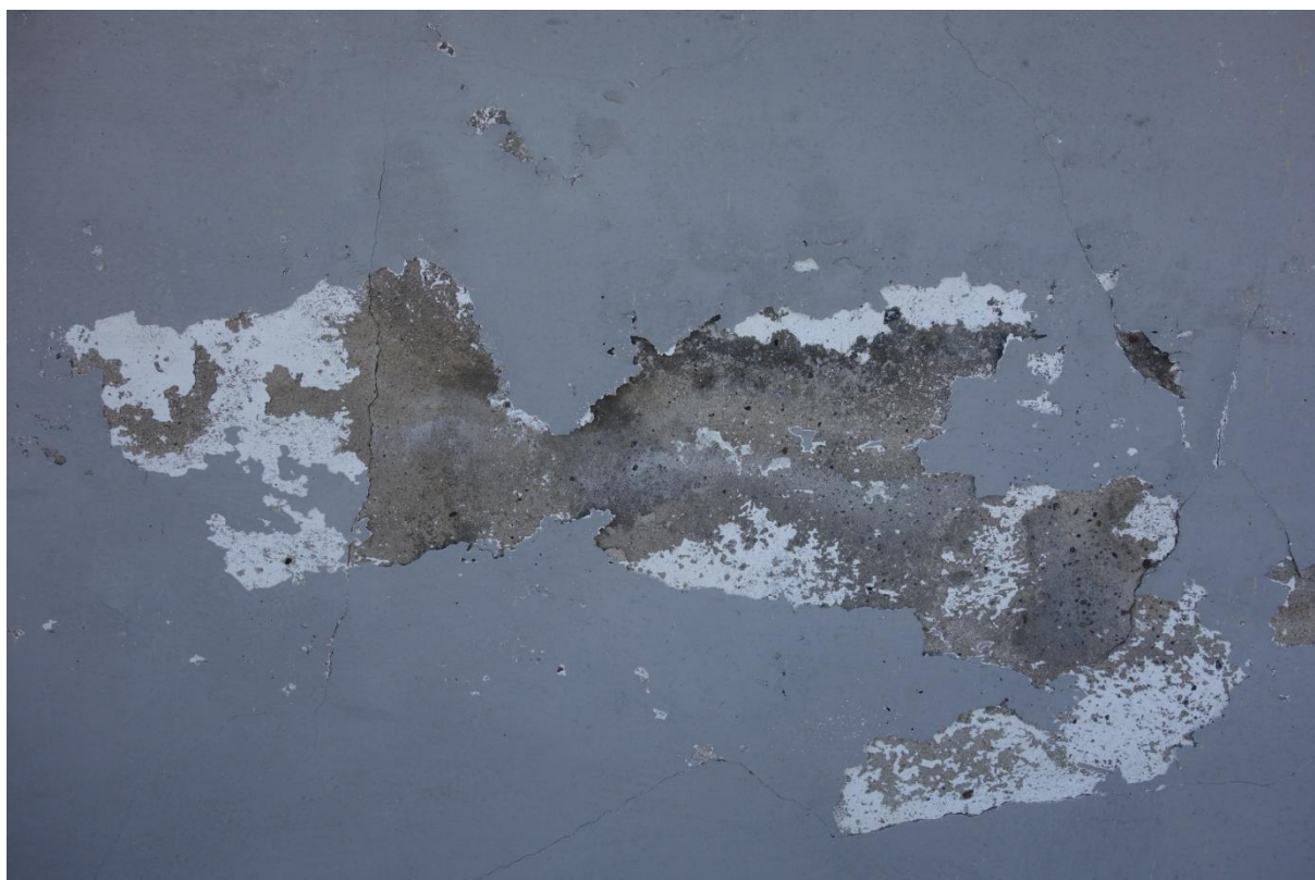
Fot.8 Widok na fragment cokołu od strony południowo-wschodniej.
