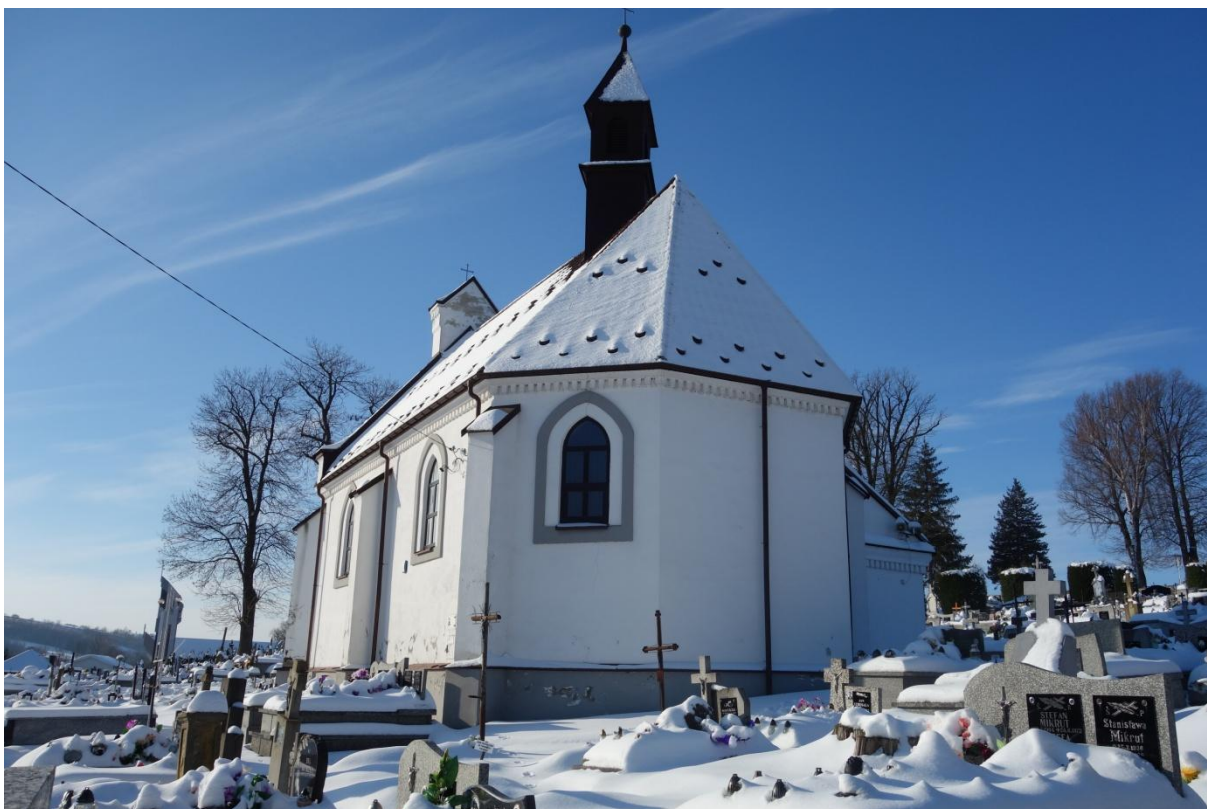
Fot. 4 Widok od strony wschodniej.
