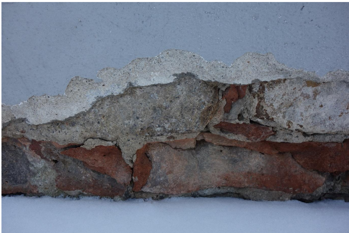
Fot.9 Widok na cokół od strony zachodniej.
