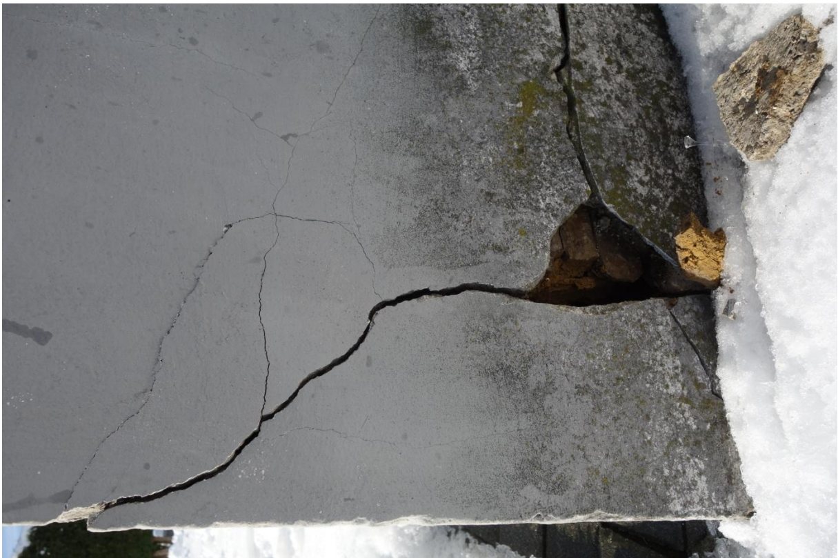
Fot.12 Widok fragmentu przypory w przyziemiu.
