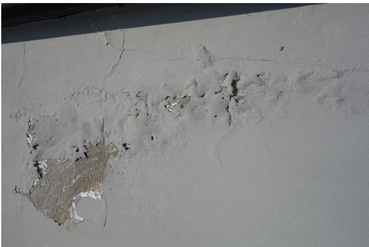
Fot.10 Widok na cokół od strony południowo-wschodniej.
