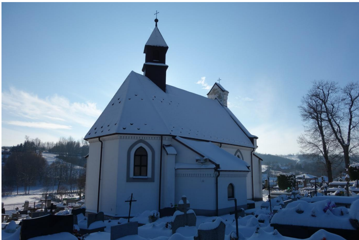
Fot. 3 Widok od strony północnej.
