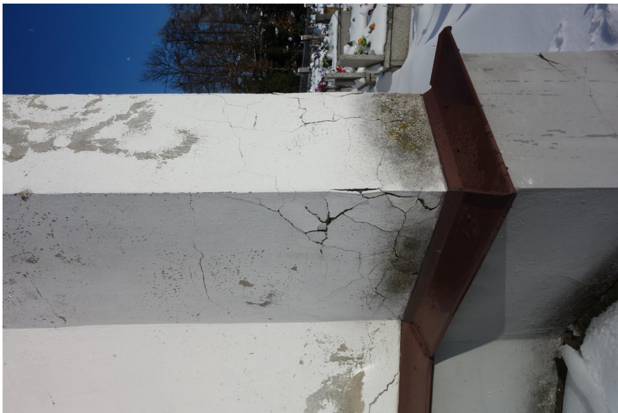
Fot.5 Widok na narożnik przypory od strony południowej.
