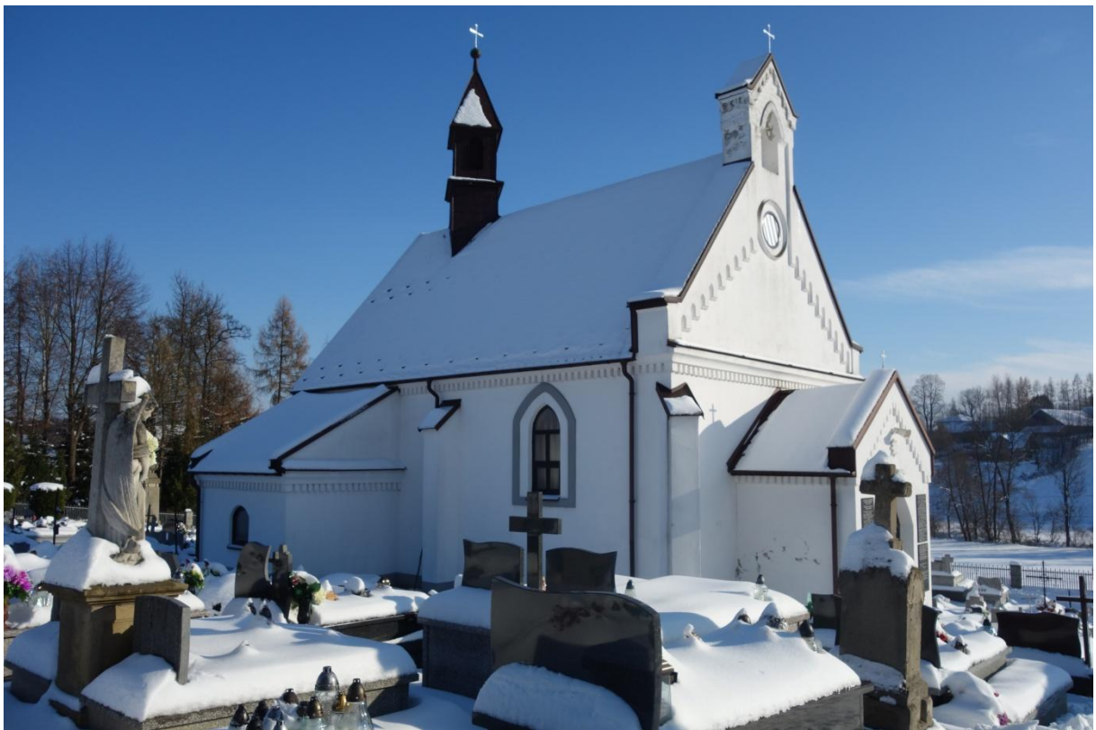
Fot.2 Widok od strony zachodniej.
